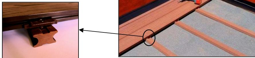
Počáteční a koncové prkno se připevňuje k podkladovému rámu napřímo vruty přes boční drážku. Jedním vrutem zafixujte stejným způsobem rovněž každé další prkno v polovině jeho délky.
