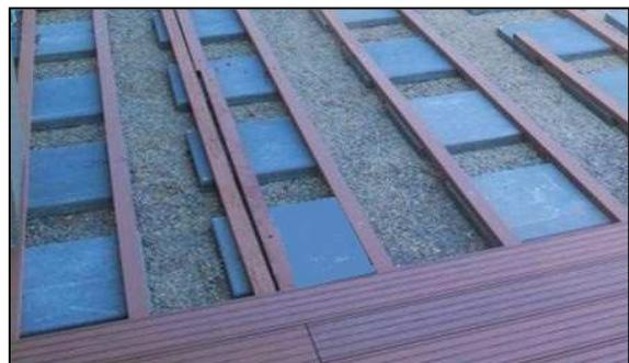
Podkladový rám by měl ležet větší částí na pevném podkladu, to znamená, že v případě použití dlaždic 40x40cm jsou optimální rozestupy mezi dlaždicemi 300mm v podélném směru prken a 200mm v jejich příčném směru.
